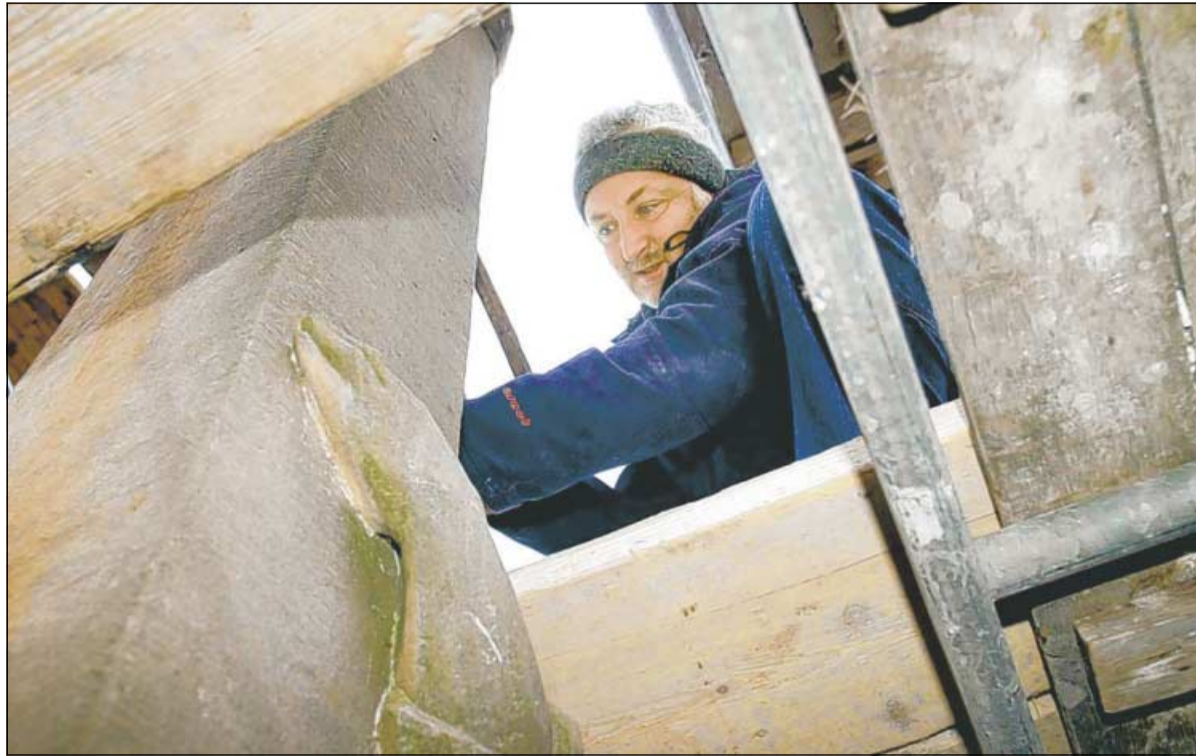
Einhalb Tage lang behutsam die Kreuzigungsgruppe abgebaut: Bildhauer Siegfried Keller bei den Arbeiten auf dem Gerüst an der Kreuzung von Speyerer und Schwegenheimer Straße, nahe der Pfarrkirche. —FOTO: LENZ
