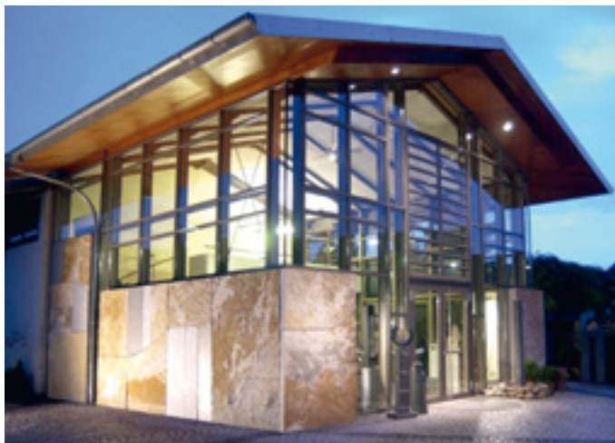
Der 6 m hohe Showroom dient als Lebens- und Arbeitsraum. Foto: Firma
